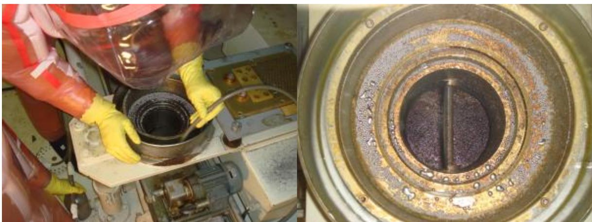
**Abbildung 1.** Links: Absaugen des Quecksilbers beim Rückbau der Chemiezellen in Jülich. Rechts: Nahaufnahme von Quecksilberresten aus den Chemiezellen in Jülich.
